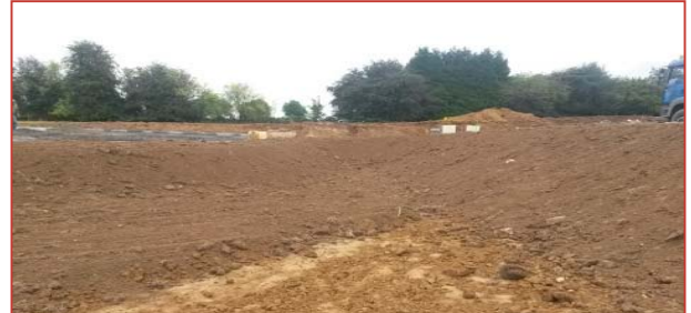
Recapage de la terre végétale
