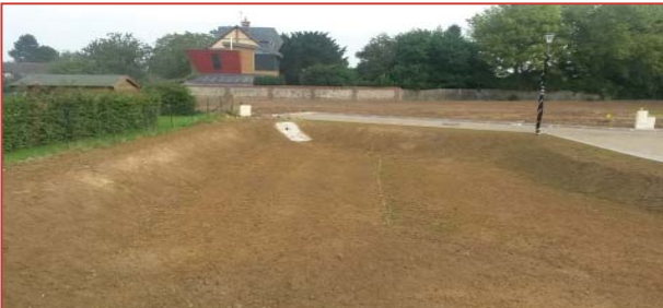
Finition des terrassements
