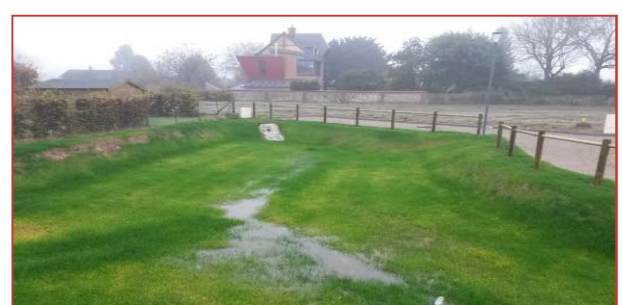
Première mise en eau de l'ouvrage
