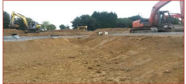
Réalisation des terrassements
