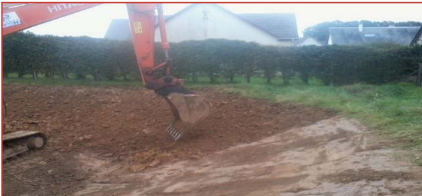
Décompactage et griffage
